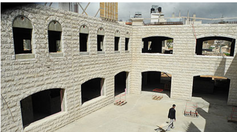
Lifegate Rehabilitation baut derzeit ein neues Zentrum für Behinderte in Beit Jala
