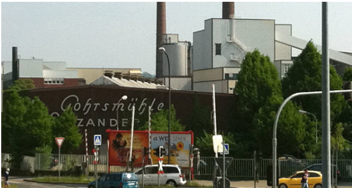
Der alte Gohrsmühle-Schriftzug am Werk von Metsä Board Zanders
