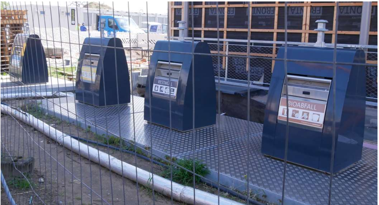
Müll wird demnächst unterirdisch gesammelt.
