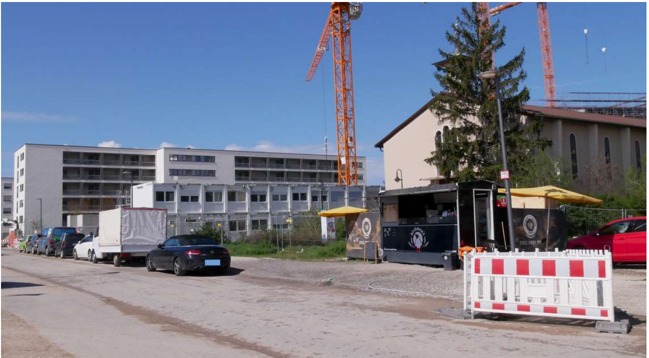
Links die schon umgebauten Baracken; rechts die ehemalige Militärkapelle, die erhalten bleibt. Unter Denkmalschutz steht keins der Gebäude.
