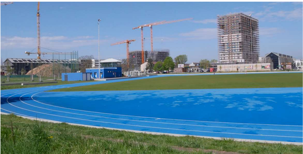
Der Sportplatz ist schon fertiggestellt; die „O“ und „E“ Hochbauten nehmen Form an.
