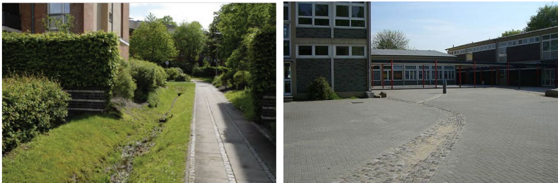
Abbildung 6-20: Offene Wasserwege aus [StEB Köln (2023)] – links und [Sieker (2023)] – rechts
