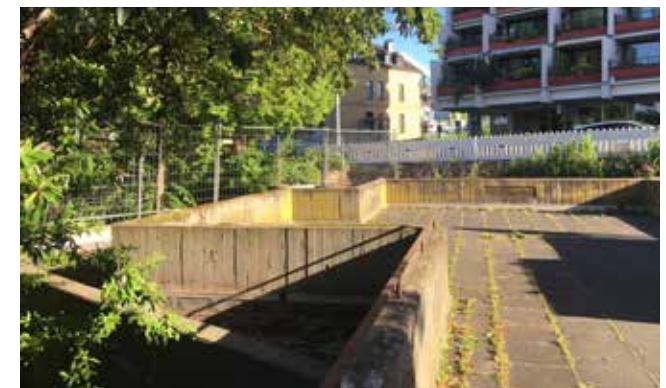
Die Brüstung und der Bodenbelag, Tiefgaragendach
