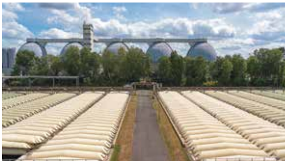
Großklärwerk Köln Stammheim Foto: Christopher C. Franken, © StEB Köln
