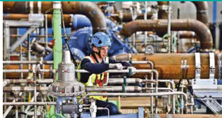
Atlas Copco Kompressor montage
