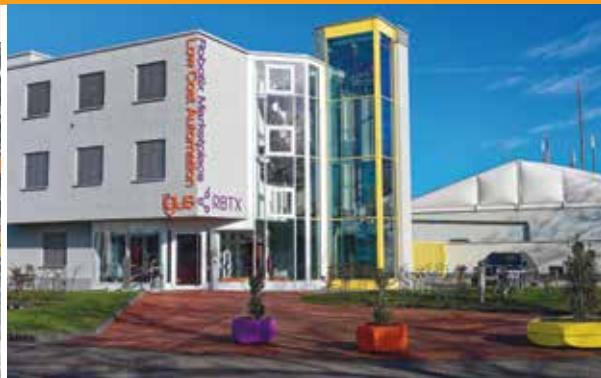
Gebäude des Geschäftsbereich Low-Cost-Automation | Alle Fotos: © igus GmbH
