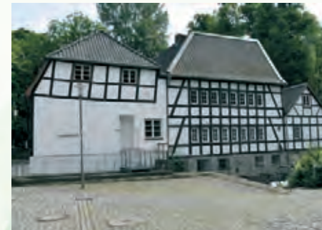
Alte Dombach | Foto: K. J. Frühlingsdorf
